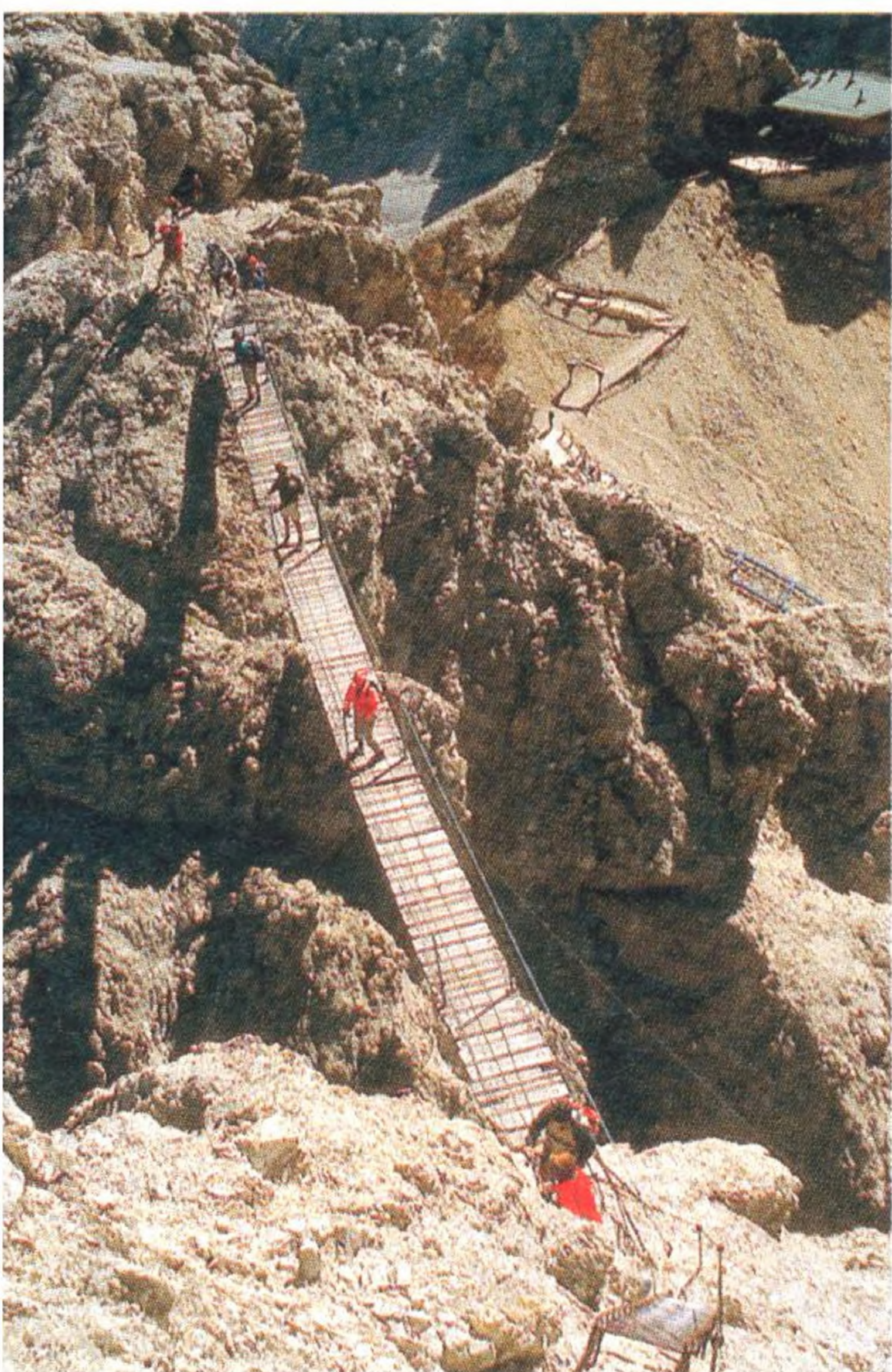
Závěsný most na zajištěné cestě Sentiero ferrato Ivano Dibona TÚRA 15
