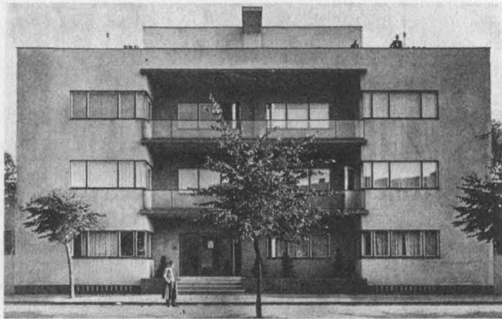
12 str. 105 OBYTNÝ DŮM ING. J. A M. NOVÁKOVÝCH Nymburk, Tyršova ulice, 1939 (realizováno)
